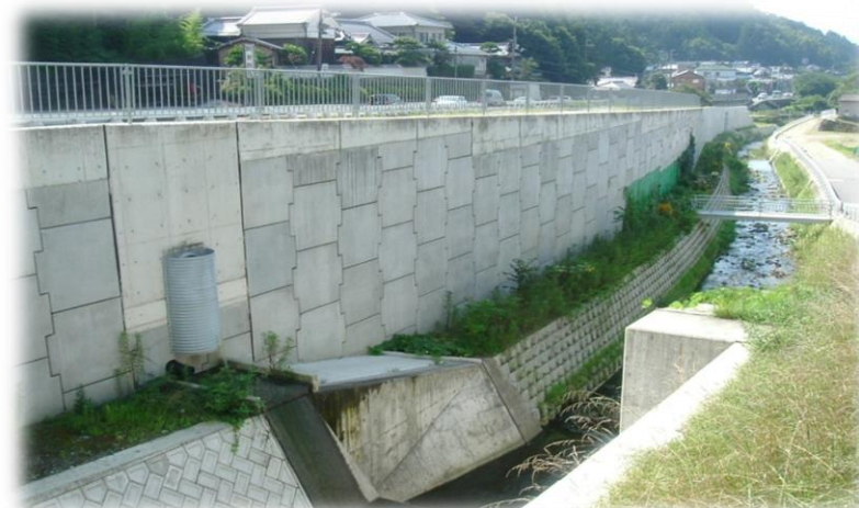
国道371号道路改良工事
