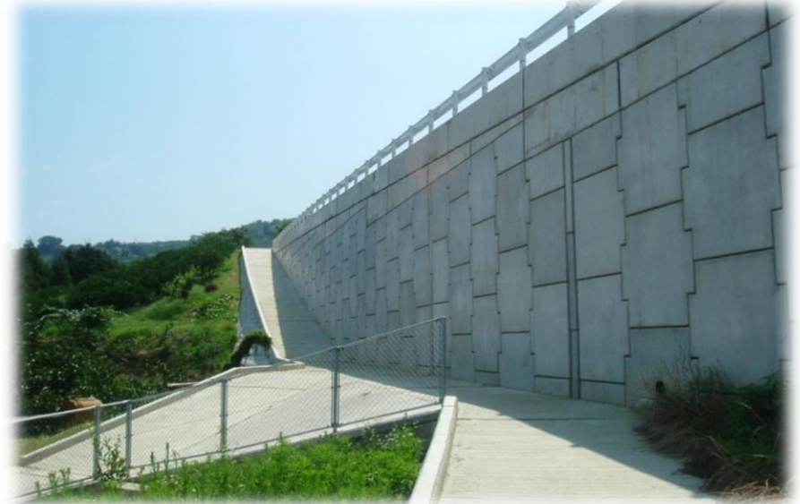
紀の川左岸地区 橋本工区南馬場道路工事
