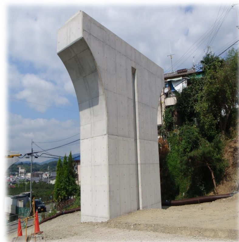
市道清水西畑線橋梁下部工事
