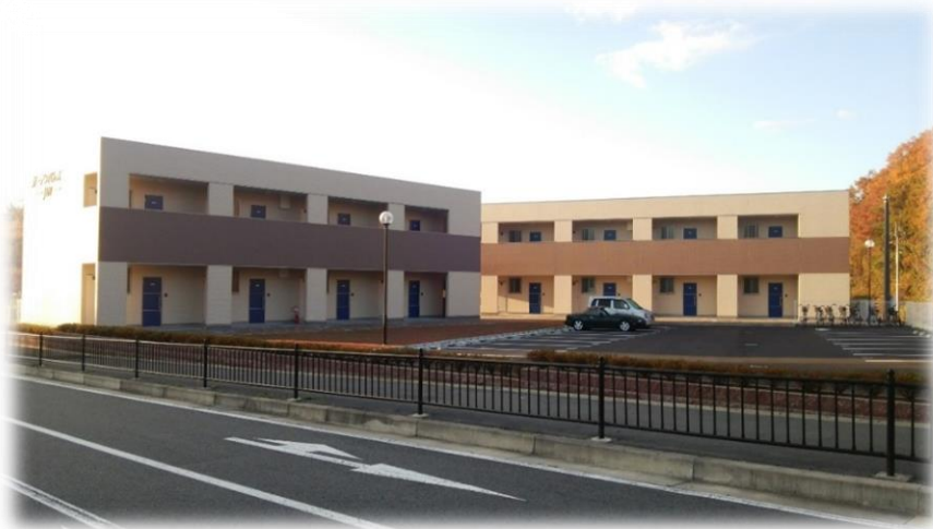
真和テック社員寮新築工事
