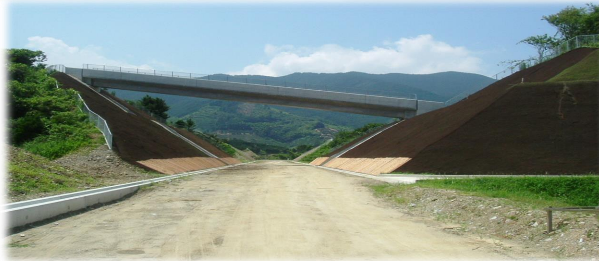
紀の川左岸地区 三谷工区法面保護工事`
