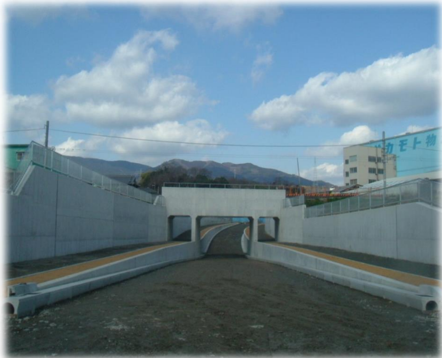
山田岸上線道路改良工事
