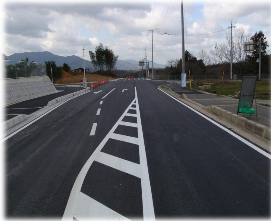
市道田原下中道路新設（その1）工事
