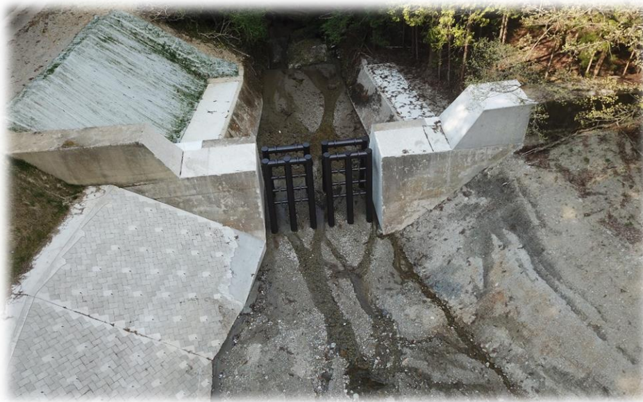
米の郷谷川砂防(砂防)工事
