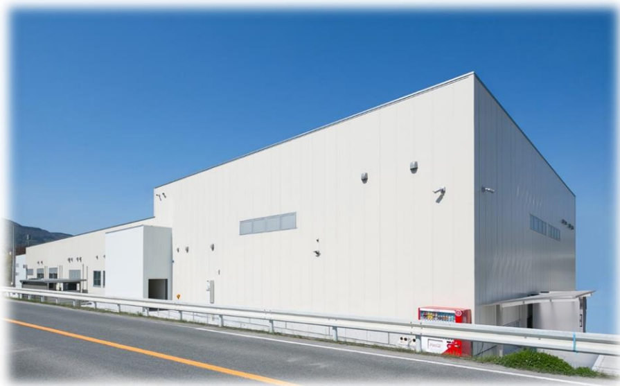
工場棟新築工事
