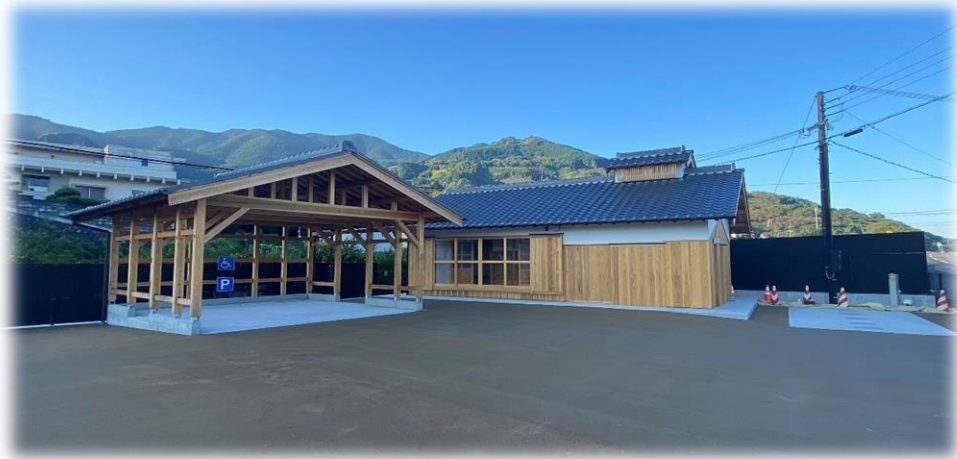
まちなみの駅(かつらぎ)建築工事
