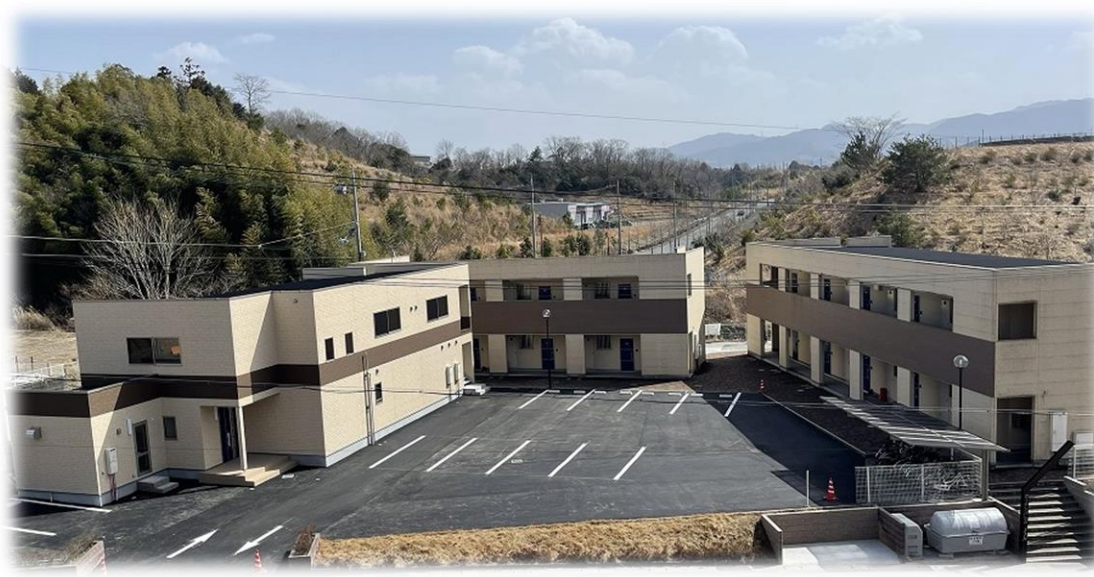
寄宿舍新築工事
