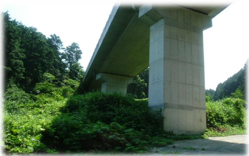
紀の川左岸地区 橋本5号橋下部工事
