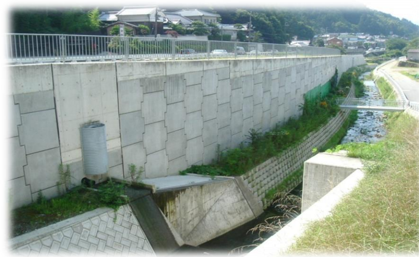
市道清水西畑線橋梁下部工事
