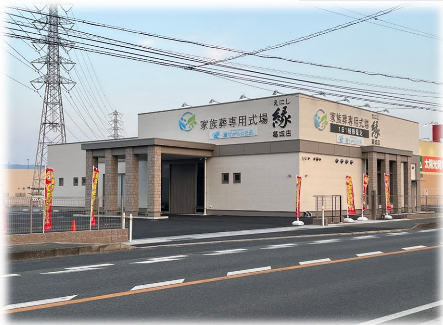
縁 葛城店新築工事
