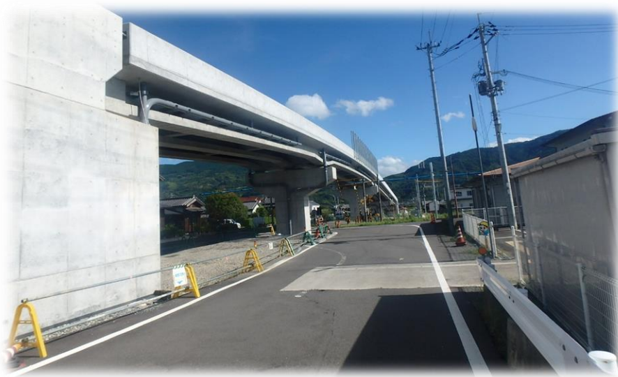
那賀かつらぎ線 道路改良工事
