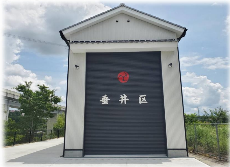
垂井区だんじり小屋新築工事
