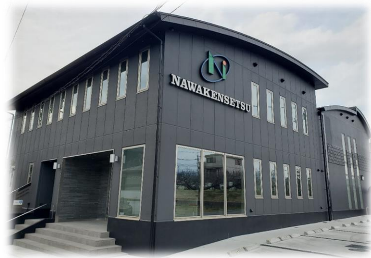
奈和建設(株) 事務所増築工事
