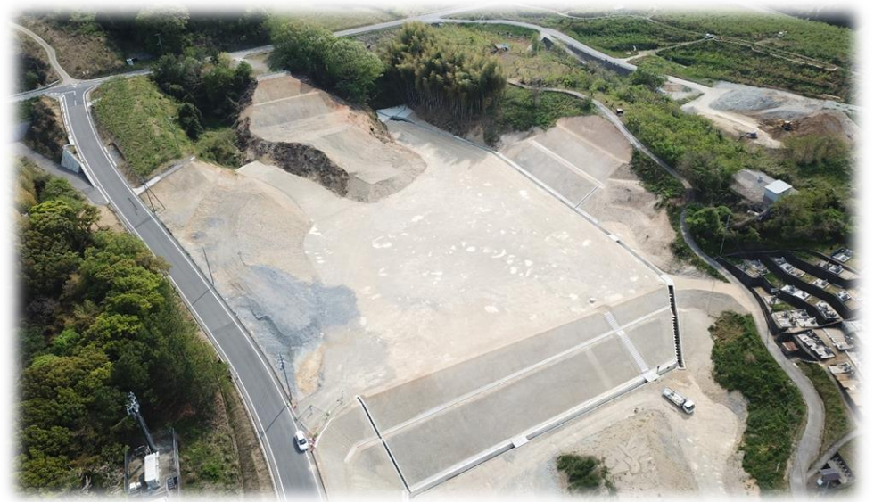
国城寮建替え用地造成工事
