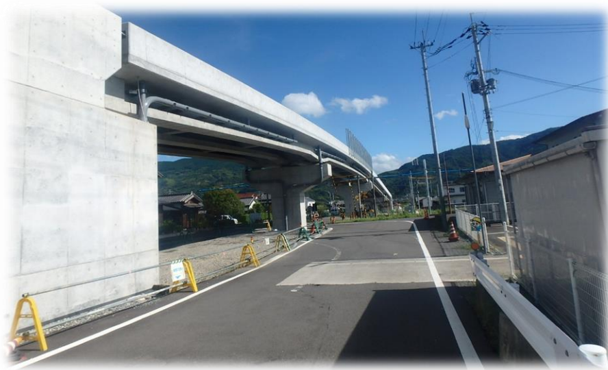
那賀かつらぎ線 道路改良工事
