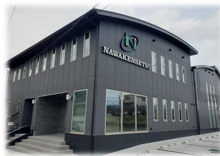
奈和建設(株) 事務所増築工事
