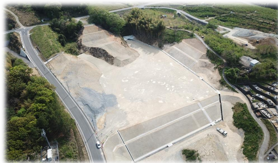
国城寮建替え用地造成工事
