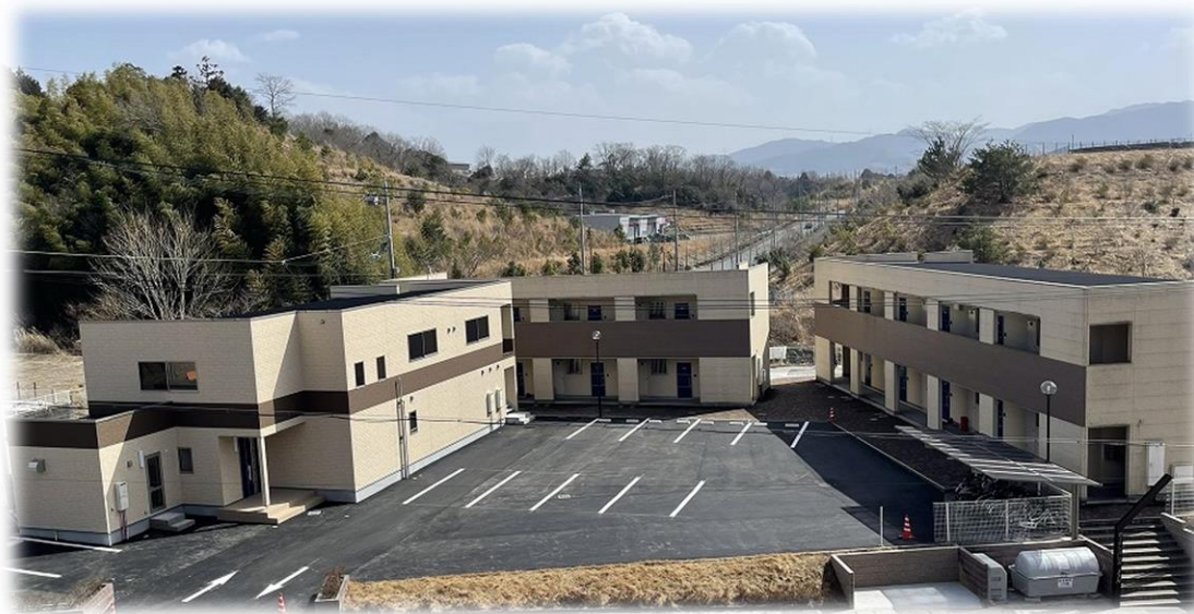
寄宿舍新築工事
