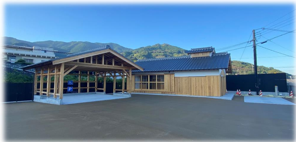
まちなみの駅(かつらぎ)建築工事
