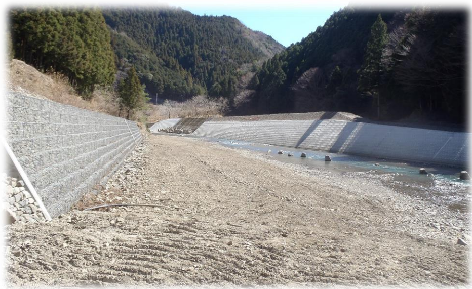
有田川 砂防工事
