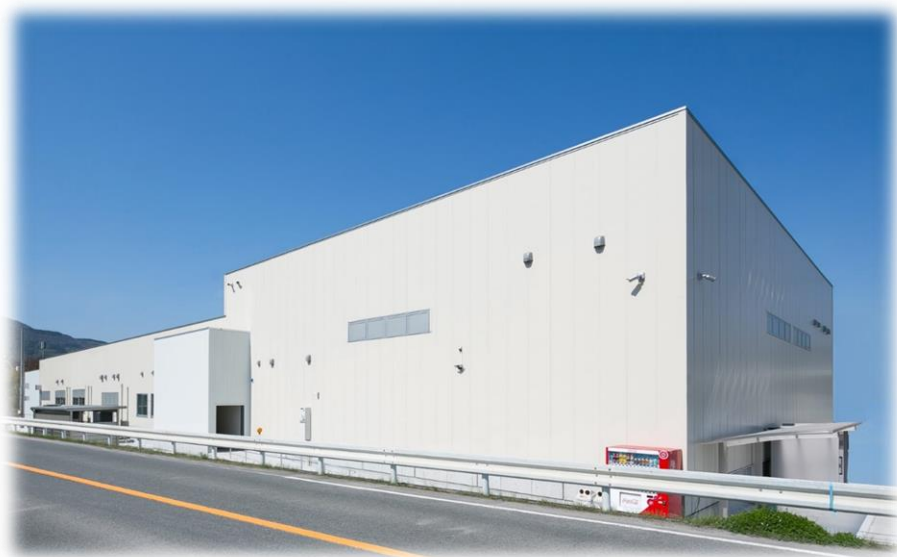
工場棟新築工事
