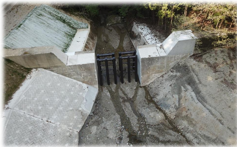
米の郷谷川砂防(砂防)工事
