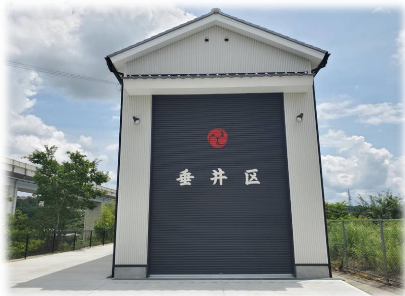
垂井区だんじり小屋新築工事
