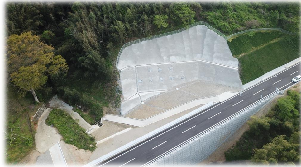
紀の川左岸地区西渋田道路(その17)工事
