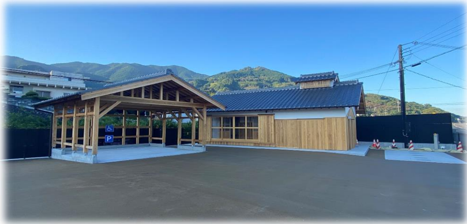
まちなみの駅(かつらぎ)建築工事
