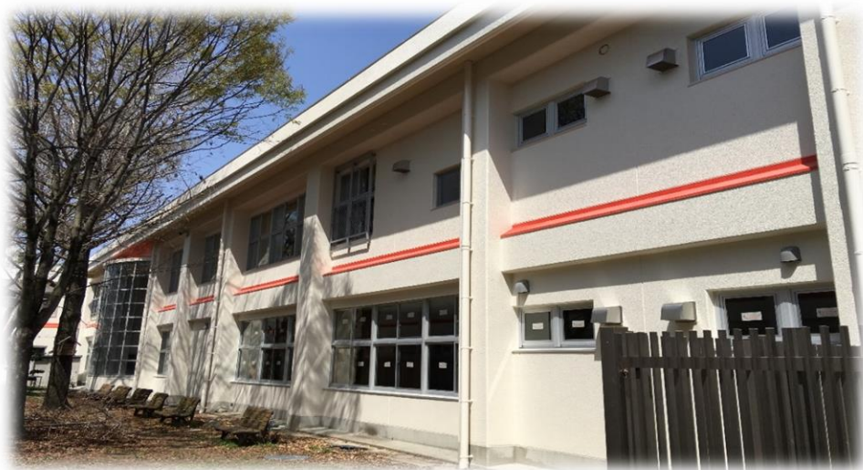
きのかわ支援学校管理棟大規模改造建築工事
