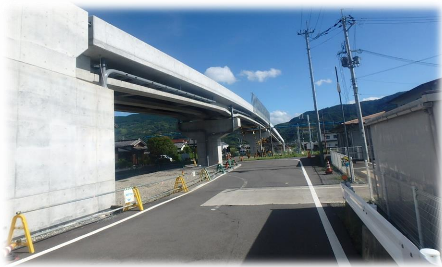
那賀かつらぎ線 道路改良工事
