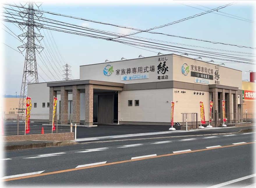
縁 葛城店新築工事
