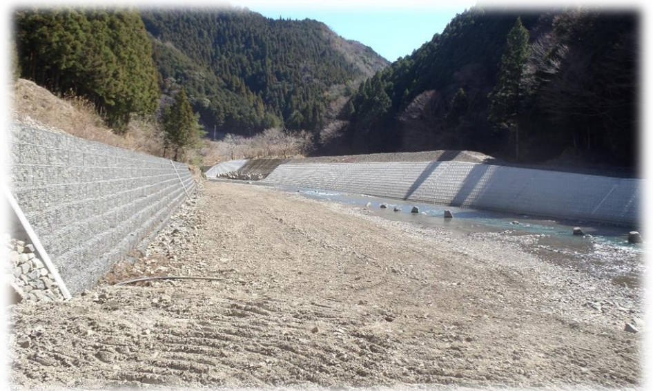
有田川 砂防工事
