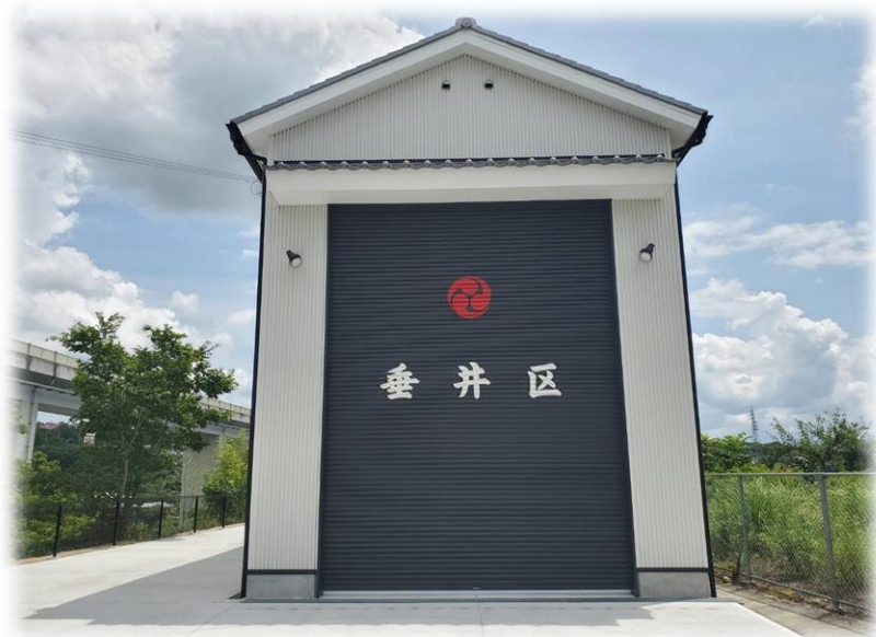
垂井区だんじり小屋新築工事
