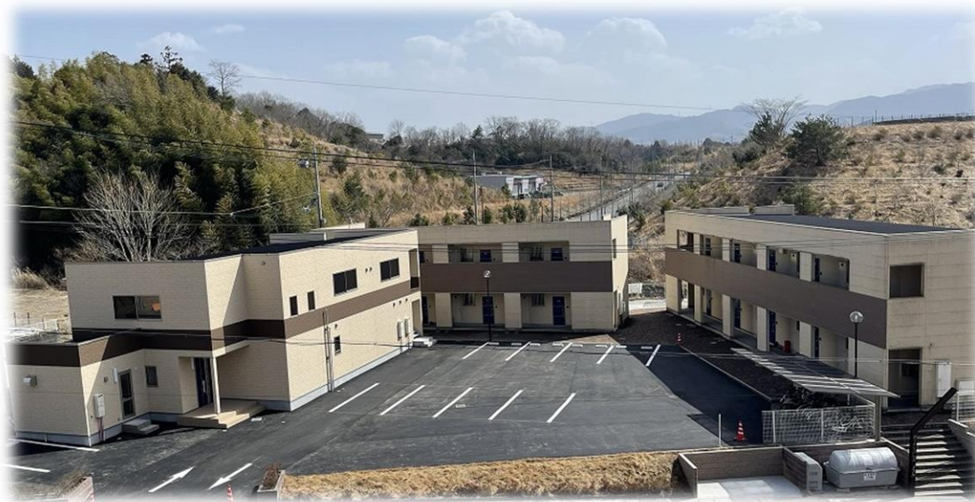
寄宿舍新築工事
