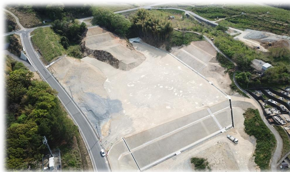
国城寮建替え用地造成工事
