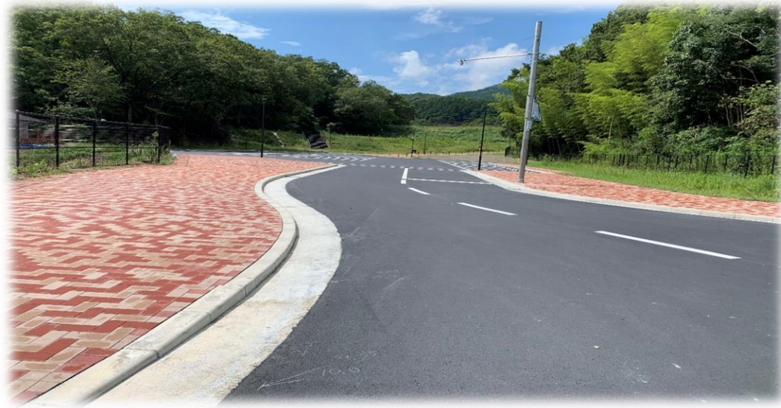
橋本市 杉村公園駐車場整備工事
